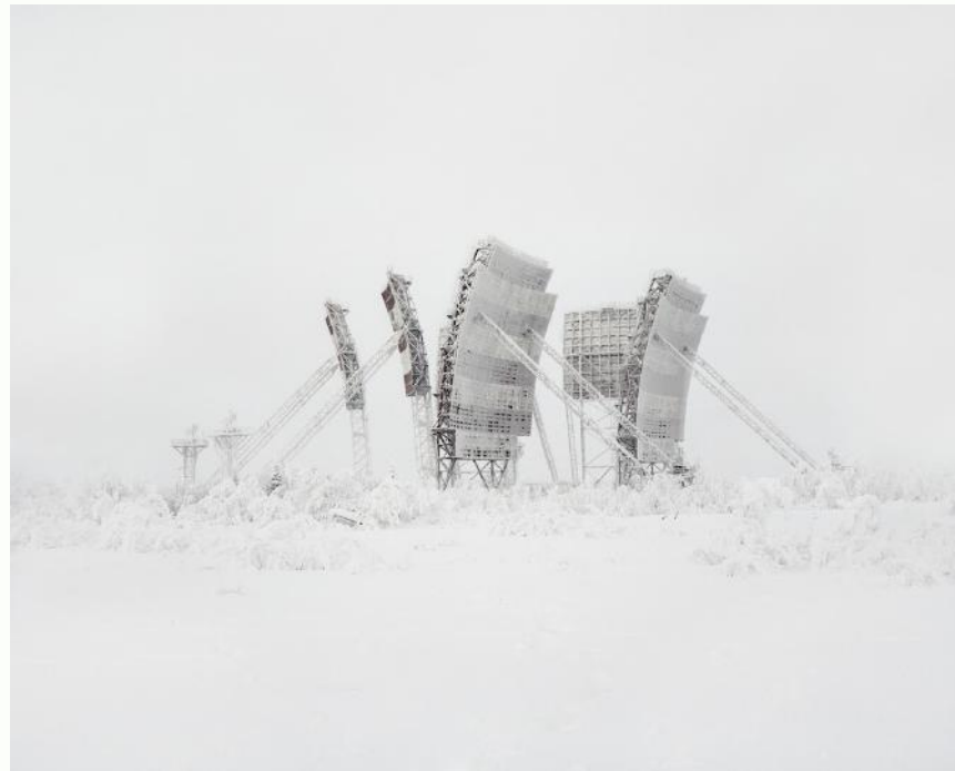
Russia, Distretto autonomo di Yamalo-Nenets, 2014 Antenne troposferiche nella Russia settentrionale. Molte antenne come queste, oggi abbandonate e obsolete, furono installate nell'estremo nord del paese.
