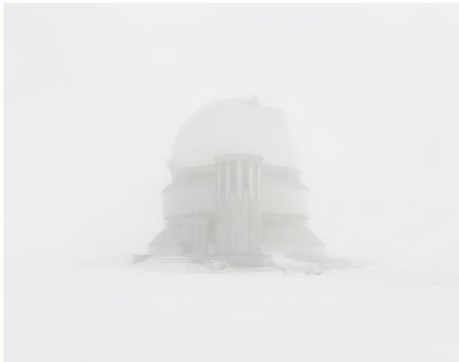
Kazakistan, regione di Almaty, 2015 Osservatorio abbandonato costruito in un'area in cui le condizioni per l'osservazione dello spazio sono ottimali.
