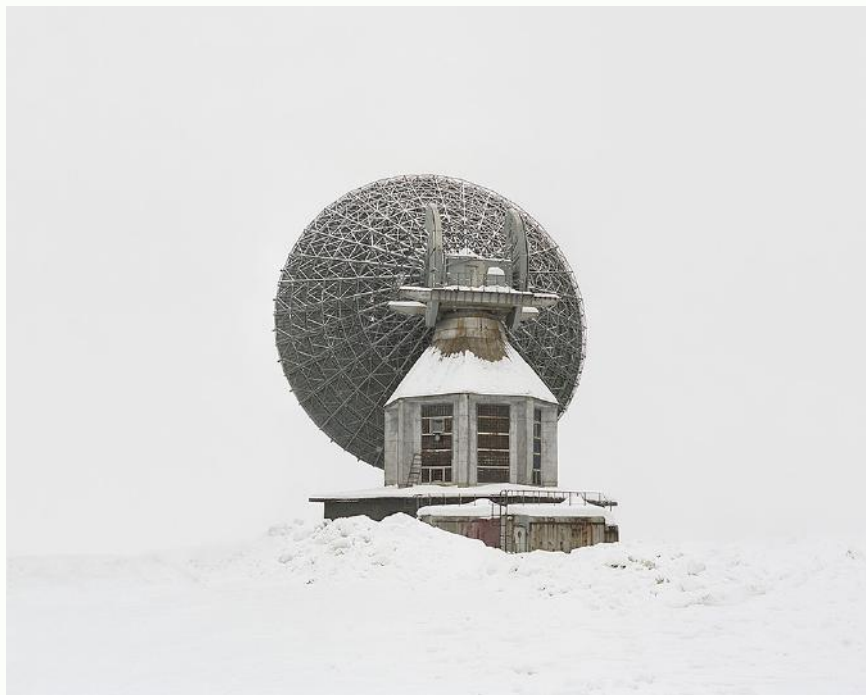
Russia, regione di Arkhangelsk, 2013 Antenne per il collegamento interplanetario. L'Unione Sovietica progettava di costruire basi su altri pianeti e approntò anche impianti che non sono mai stati utilizzati e oggi sono abbandonati.
